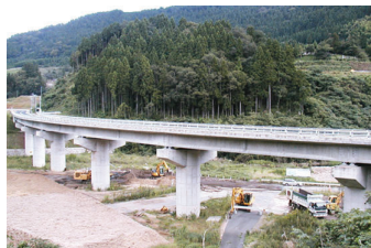
軟弱地盤上のPC橋梁、橋脚
